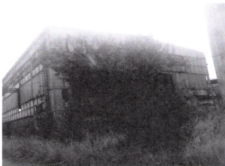
Figura 4-5: Inchidere laterala cu azbociment, cu deteriorare avansata
